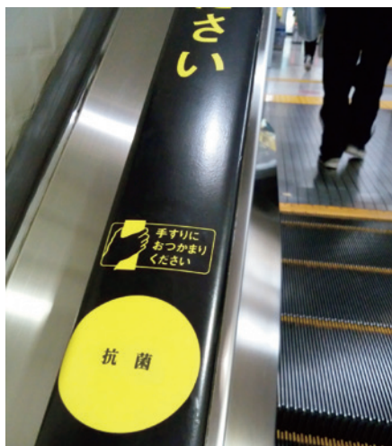
抗菌加工されたエスカレーターの手すり
